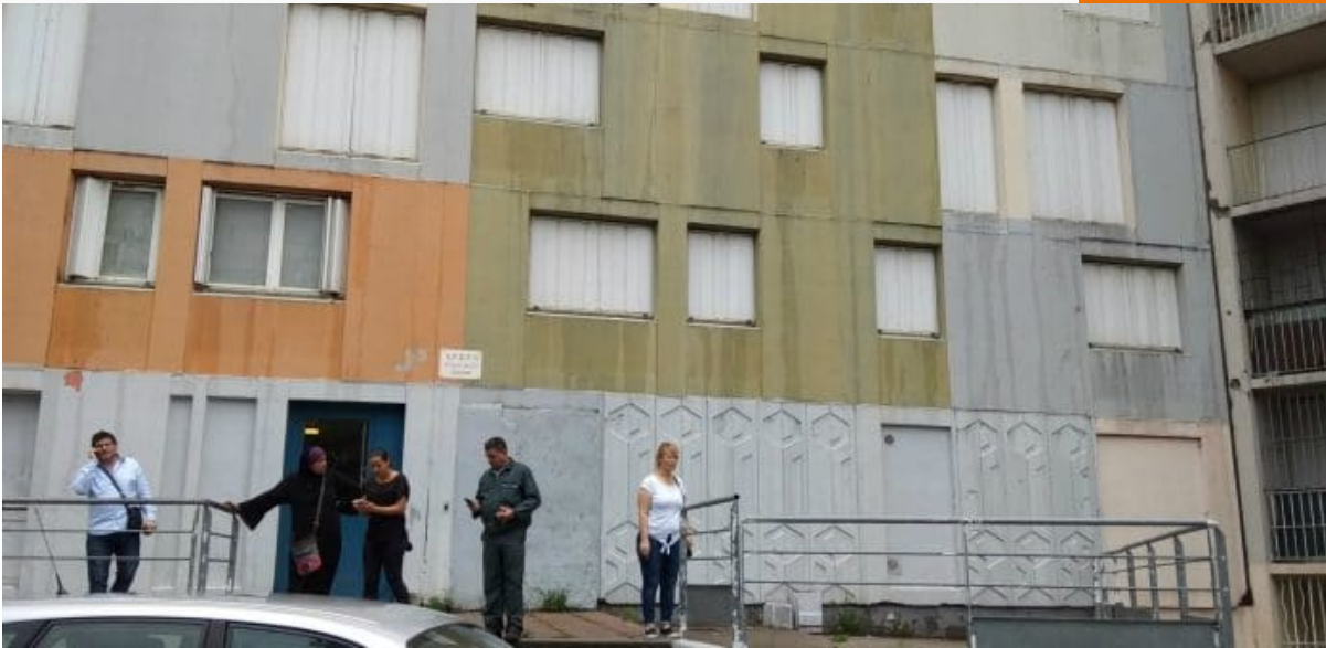
Dans tout le bâtiment J, les fenêtres sont fermées, parfois murées.
